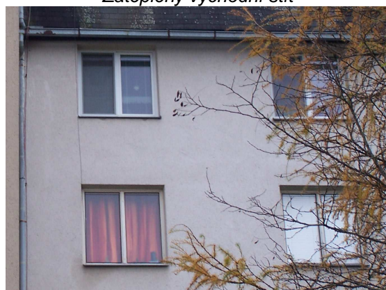
Okna původní dřevěná a nová plastová
