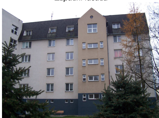
Dvorní východní fasáda
